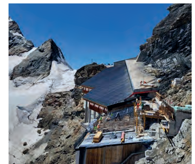
Auf 3450 m ü. M. kann nur von Juni bis Oktober gebaut werden. Das Baumaterial gelangte mit der Jungfraubahn auf den Berg und anschliessend mit dem Helikopter auf das Dach des Gletscherrestaurants.
